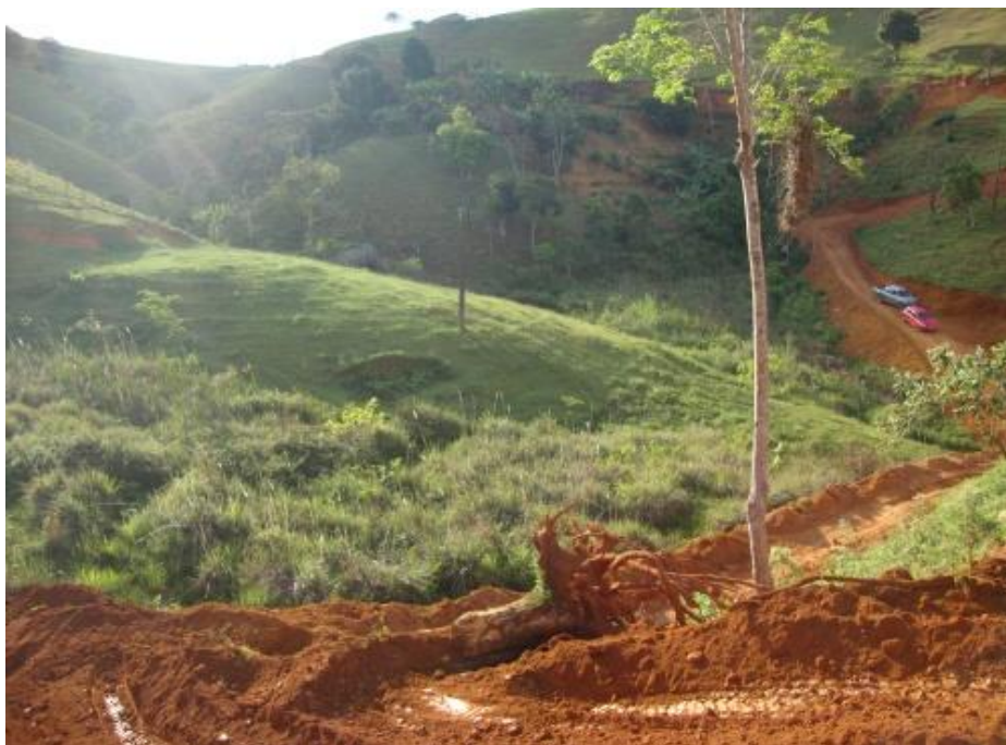
Fotografia 29: Cascalhamento, patrolamento e abertura de estradas na localidade rural do Sossego, Barra do Choça/BA, em 27 de abril de 2015
