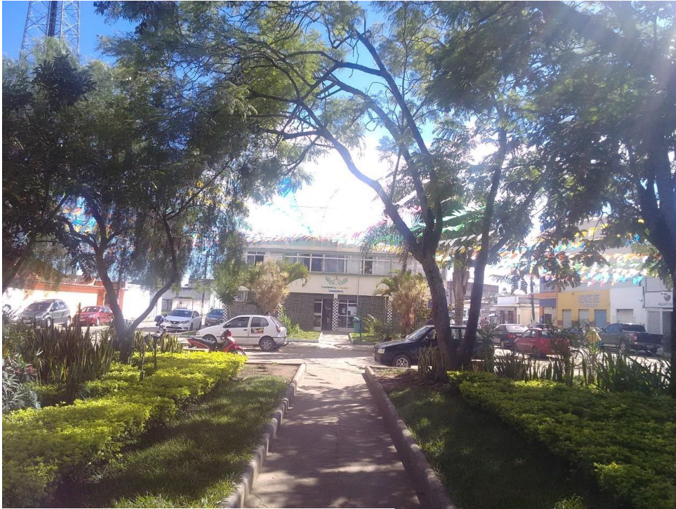
Fotografia 8: Prédio da Prefeitura Municipal de Barra do Choça/BA, 2018
