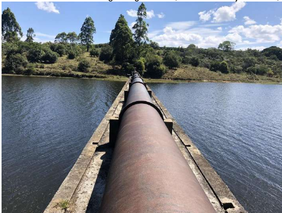
Foto 6 – Adutora da Barragem Água Fria II, Barra do Choça – Bahia, 2019.
