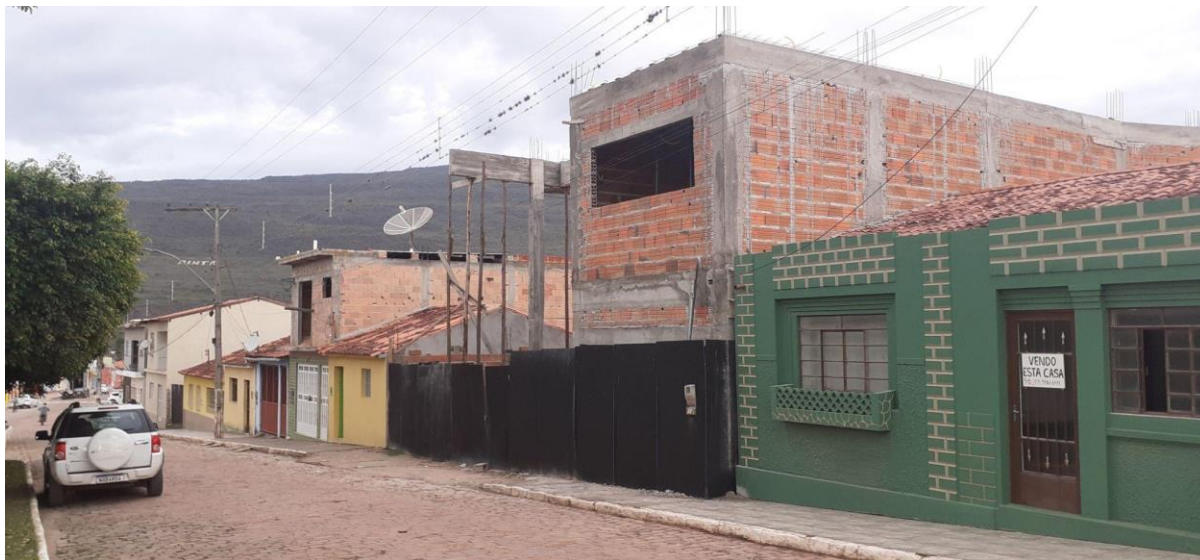
Fotografia 5 - Verticalização no Centro de Piatã-BA, 2022
