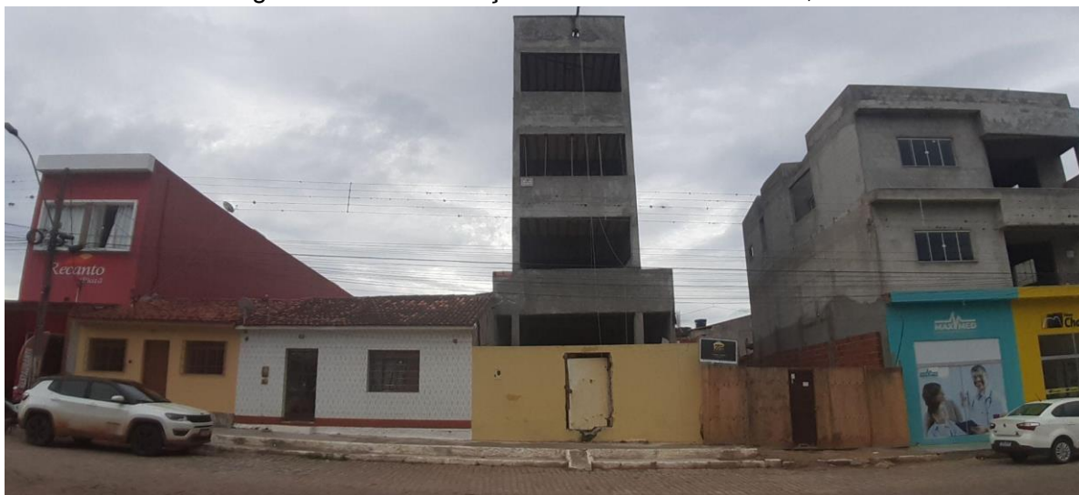
Fotografia 4 - Verticalização no Centro de Piatã-BA, 2022
