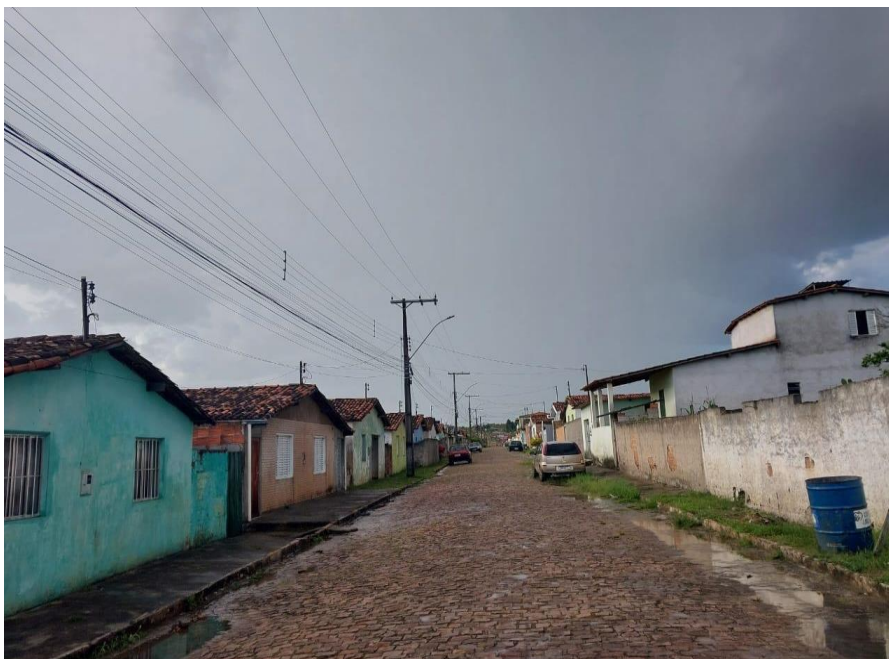
Fotografia 13 - Rua no Bairro Tangará, Piatã-BA, 2022
