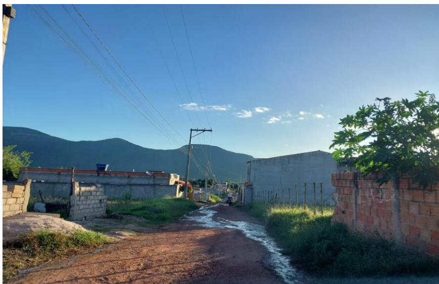
Fotografia 28 - Rua com esgoto a céu aberto na área de expansão em Piatã, 2022
